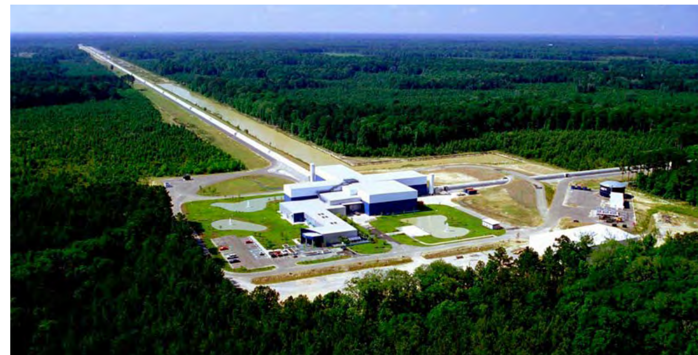
Um dos dois experimentos gêmeos do LIGO, na Louisiana. Note os dois braços perpendiculares, cada um com cerca de 4 km, que partem do prédio central onde fica a fonte laser que emite um feixe que, depois de dividido, percorre cada um dos dois braços para, então, se juntar novamente no ponto de partida. Créditos: Prof. Dulcideo Braz Júnior ( veja mais ).
