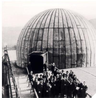
Cúpula da fábrica da Zeiss em três fases de construção. À direita, o esqueleto geodésico, ao centro, conclusão da aplicação do cimento e sem seguida, já com o revestimento por placas de cobre. Fotos: Zeiss Optical.
