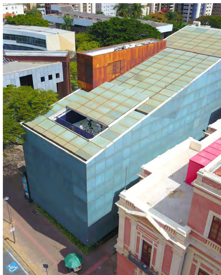
Prédio do Espaço do Conhecimento UFMG vista por um drone. Foto de Camila de Oliveira.
